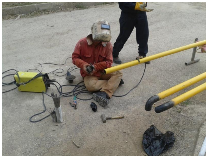
شکل ۳-۴: نصب تعدادی از زانویی‌ها روی خط لوله و قبل از نصب آن روی دیوار
