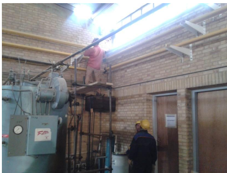
شکل ۳-۵: جوشکاری لوله‌ها به هم در روی دیوار
