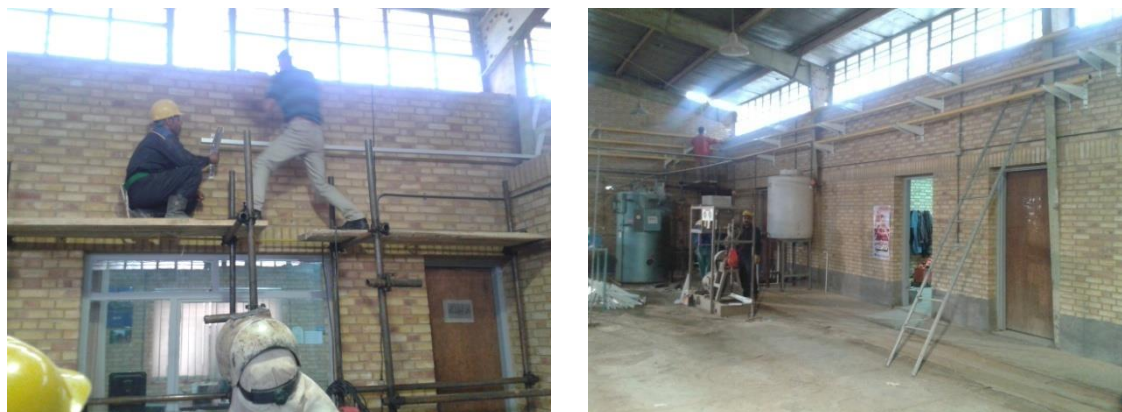
شکل ۳-۲: نصب ساپورت‌های لوله از نوع ساپورت‌های کولر گازی
