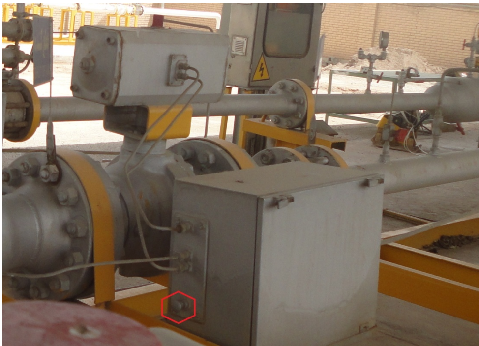
شکل ۲-۳: ضامن تعبیه شده بر روی شیر قطع جریان
